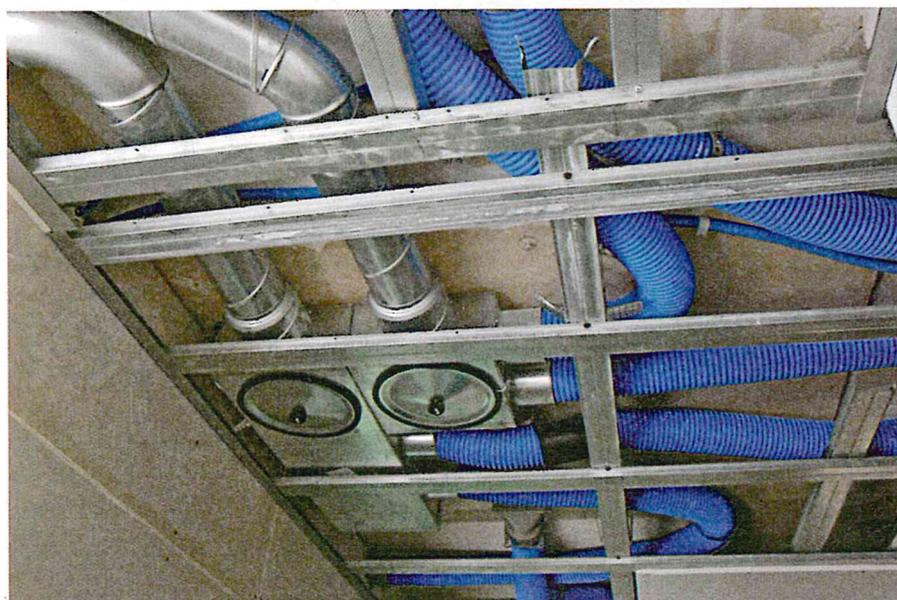
In der Korridordecke ist die Lüftungsverteilung untergebracht; die Giesserei ist ein Minergie-P-Bau.
