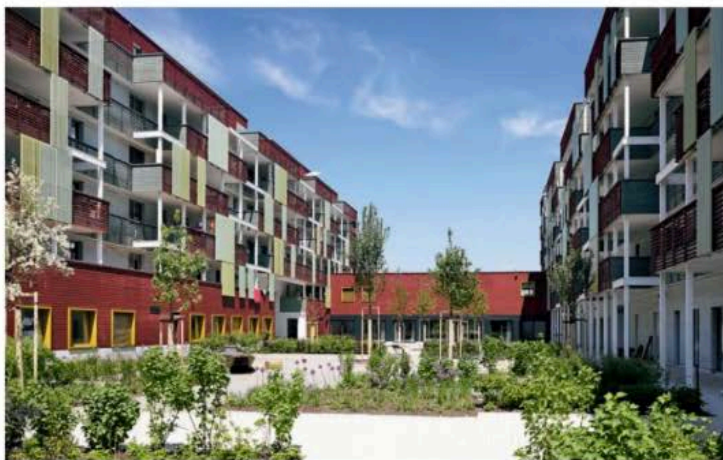
Der Innenhof wurde von den Landschaftsarchitekten Rotzler Krebs nach den Wünschen der Siedler mit Gartennischen, Spielbereichen und einem Platz mit Brunnen gestaltet.
