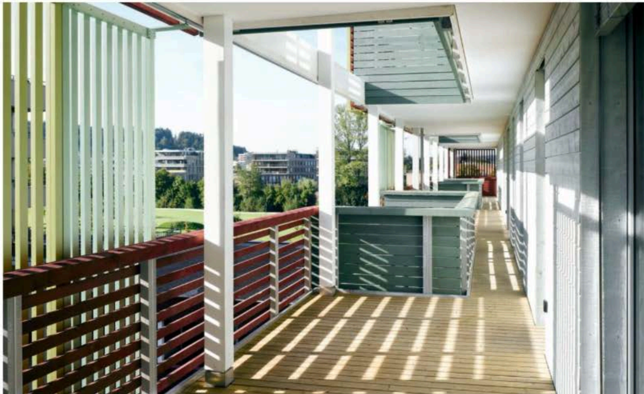
Horizontale Lattungen und vertikale Schiebeelemente filtern das Licht auf den Loggien. Die Brüstung springt vor und zurück, definiert damit Zonen. Schmale Stege erlauben jedoch, die gesamte Loggia zu betreten und machen sie damit zugleich zu einem Gemeinschaftsraum.
