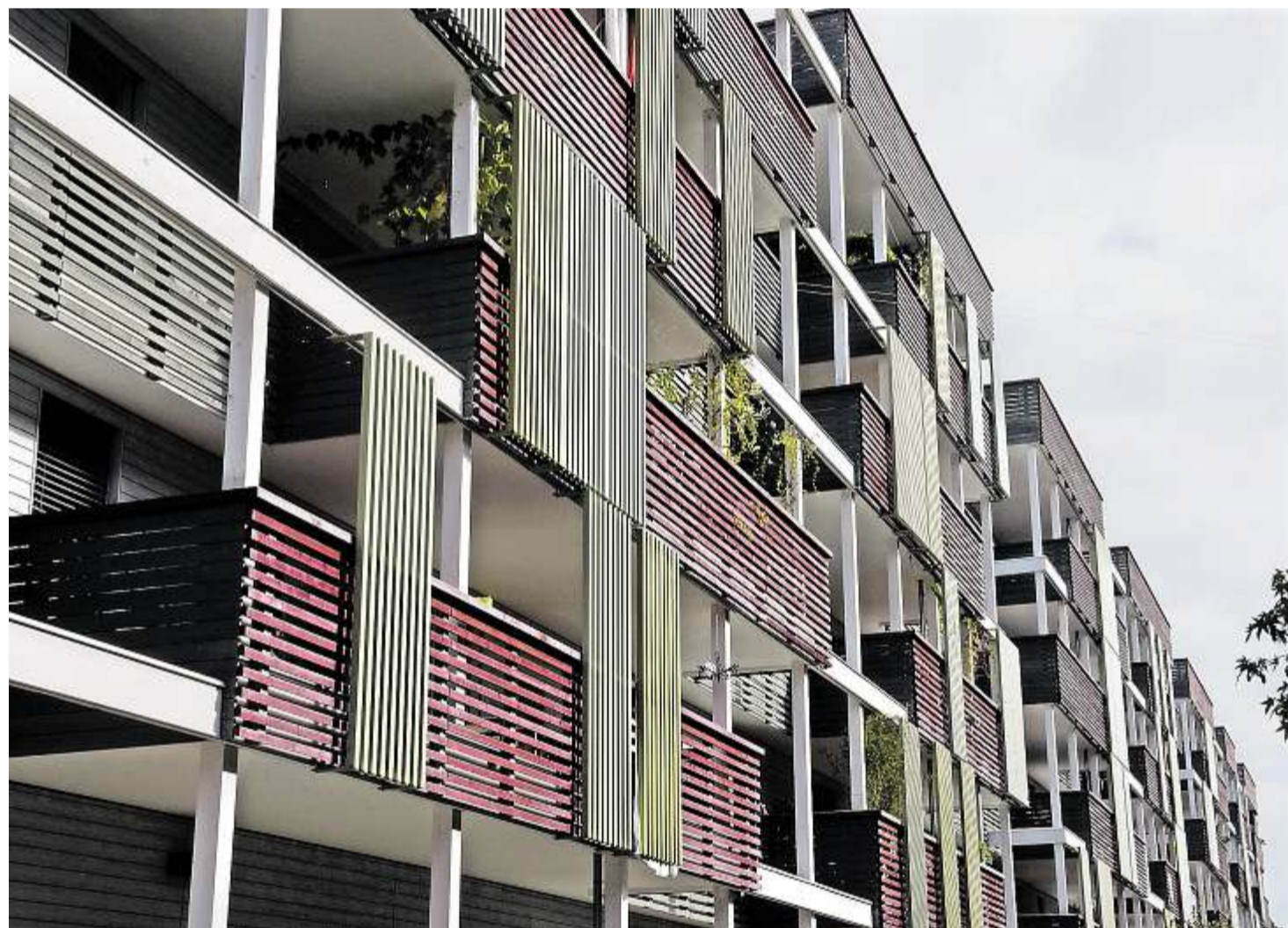
Die Giesserei an der Ida-Sträuli-Strasse ist Minergie-P-Eco zertifiziert und gemäss der Jury ökologisch, sozial und ökonomisch wegweisend. Neben inneren Werten überzeugte die Jury aber auch die Architektur, die zeigt, was Holz im grossen Massstab leisten könne. Heinz Diener
